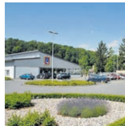
Illegal. Dieser Aldi in Lausen hätte nicht bewilligt werden dürfen.
